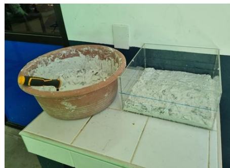
1d: Colocación de aceite y mezcla en el encofrado.
