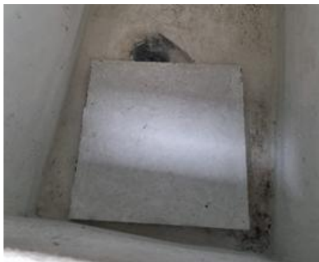
1e: Desencofrado y curado.
